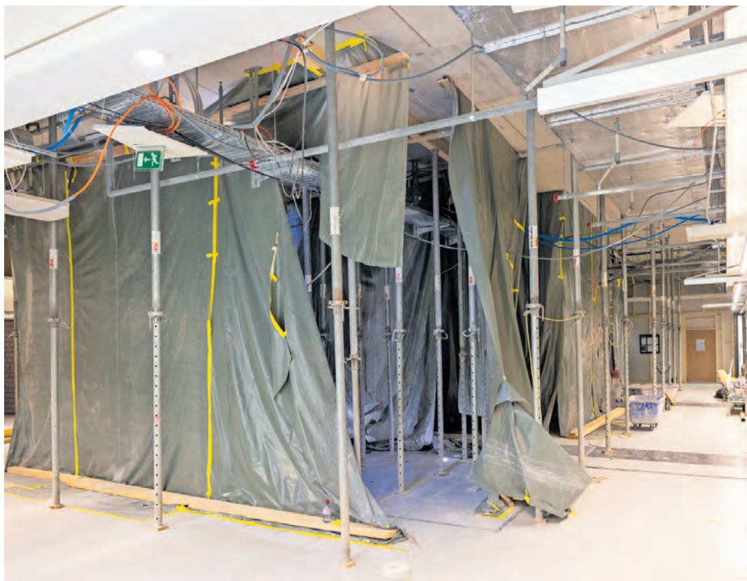
Baustelle im Obergeschoss und auf dem Dach: Hier wird das Dach durchbrochen, um mehr Tageslicht ins Center zu bringen.
