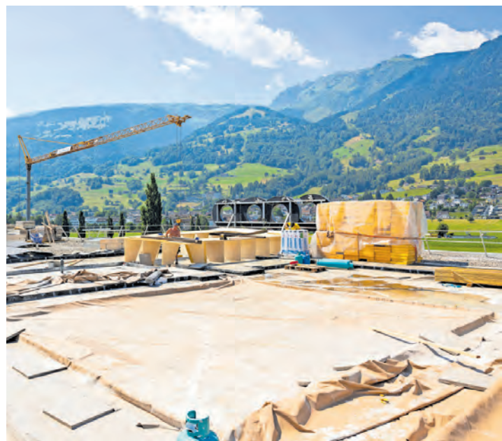
Baustelle im Obergeschoss und auf dem Dach: Hier wird das Dach durchbrochen, um mehr Tageslicht ins Center zu bringen.
